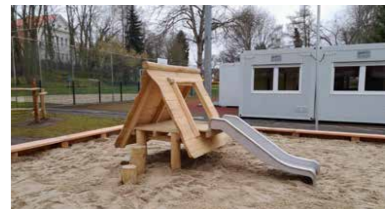
Um schnellstmöglich neue Kitaplätze in Bad Belzig zur Verfügung stellen zu können, wurden 23 Baucontainer angeliefert und aufgestellt. Wegen des geringen Platzes war das eine echte logistische Herausforderung: Alle Container mussten zunächst vom Tieflader auf LKWS umgeladen werden, um sie später am Standort der alten Eisbahn an der Martin-Luther-Straße aufbauen zu können. Auf diese Weise entstehen 40 Kitaplätze auf 420 Quadratmetern mit Außenspielbereich.
